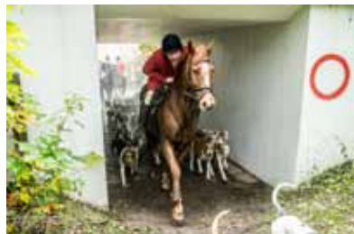
Nicht für Jagdreiter gebaut: Die Fußgängerunterführung unter der Eisenbahnstrecke am Forellenhof.
